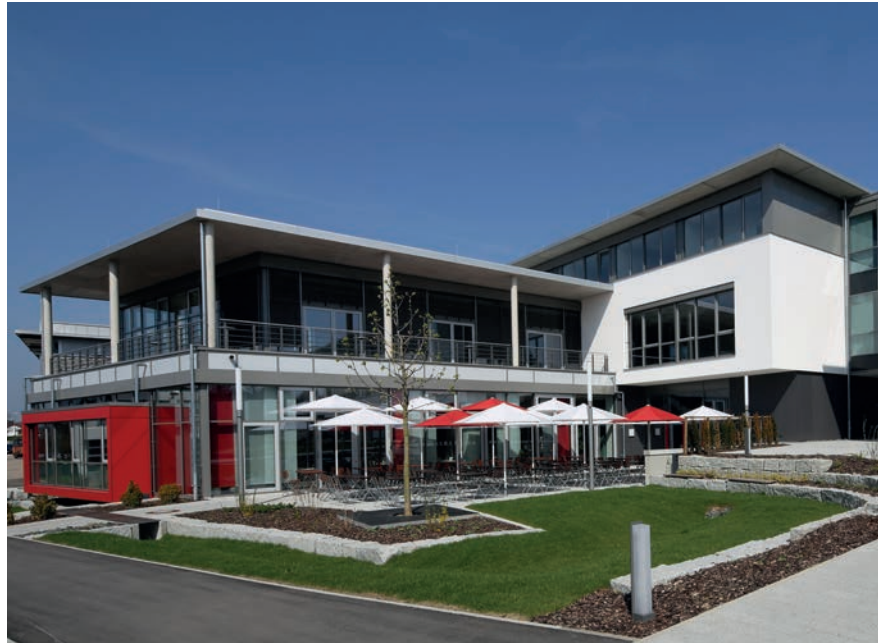
Bild 1: Innovationszentrum am ZwickRoell Stammhaus in Ulm
