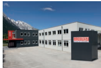
Site de fabrication de Kuchl
